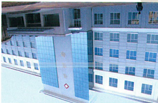
海原县人民医院住院部大楼
